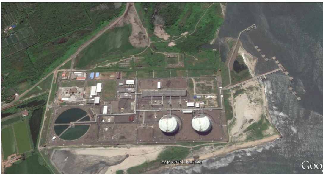
Figure 3.3 Kochi LNG Terminal
